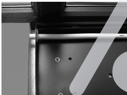
Obr. 5 Vložení opěrné a uzavírací lišty na boční stěnu vany.
