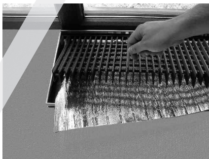
Obr. 14 Vložení termoreflexní fólie na dno vany a uložení záříče do vany radiátoru. K uložení záříče do vany slouží ruční dvojháček, který je součástí příslušenství radiátoru.
