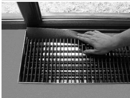
Obr. 15 Zakrytí přívodů v přípojovací komoře termoizolačními pásy.
