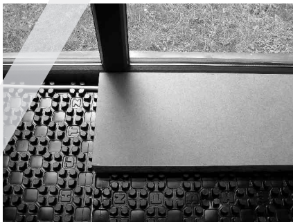
Obr. 2 Vymezení prostoru pro radiátor před betonáží podlahy šalovací formou - lze objednat s radiátorem.
